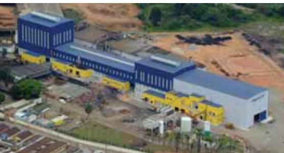
The new Höganäs Brasil plant.
